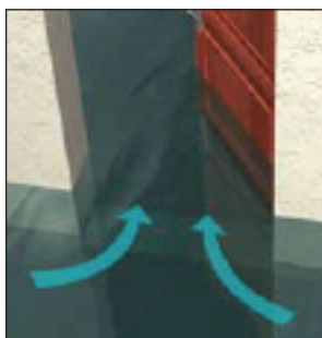
Situation initiale l'eau pénètre par les ouvertures
